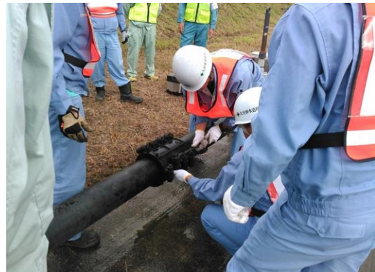
応急復旧訓練（配水管の修繕）
