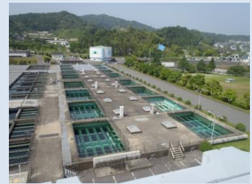
牛頸浄水場急速ろ過池
