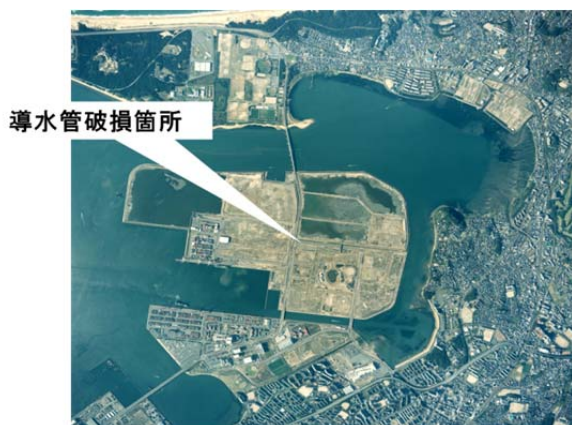
企業団導水管の被災箇所
